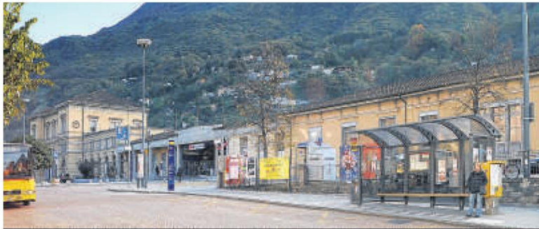
La stazione ferroviaria di Bellinzona com'è oggi...
