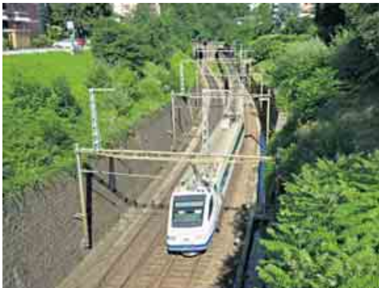
La trincea ferroviaria di Massagno.
